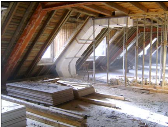
Abbrucharbeiten im Obergeschoss / Dachgeschoss – späterer Kammermusiksaal
